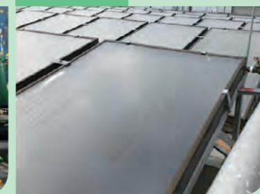
• 改進酒店太陽能熱水系統，增加膨脹水箱補水、修正循環管道，在提高系統運行穩定性的同時，顯著提升系統製熱效率。在晴天日照良好時，製熱溫度可達50°C左右，每天可生產熱水100噸。
